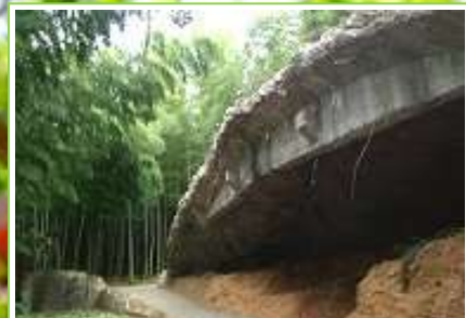
戦時中にあった八日市飛行場の軍用機を格納するためのコンクリート製の掩体壕
